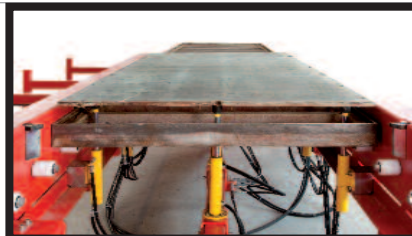
Ausdrückvorgang durch hydraulisch betätigte Stempel
